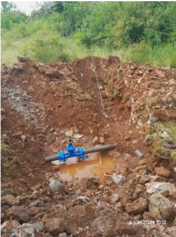
Point de raccordement « Borie de L'allé » : Ajout d'une vanne sur le PVC 90
