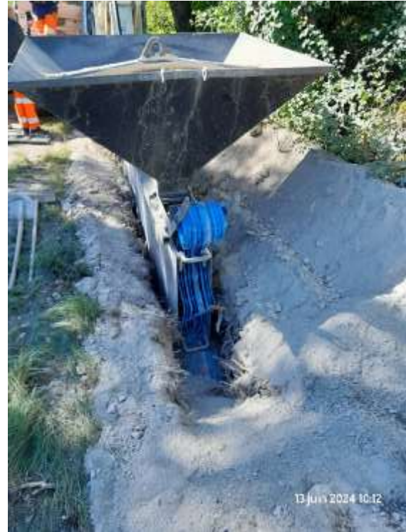
Accotement RD n°11 Pose de réseau en cours
