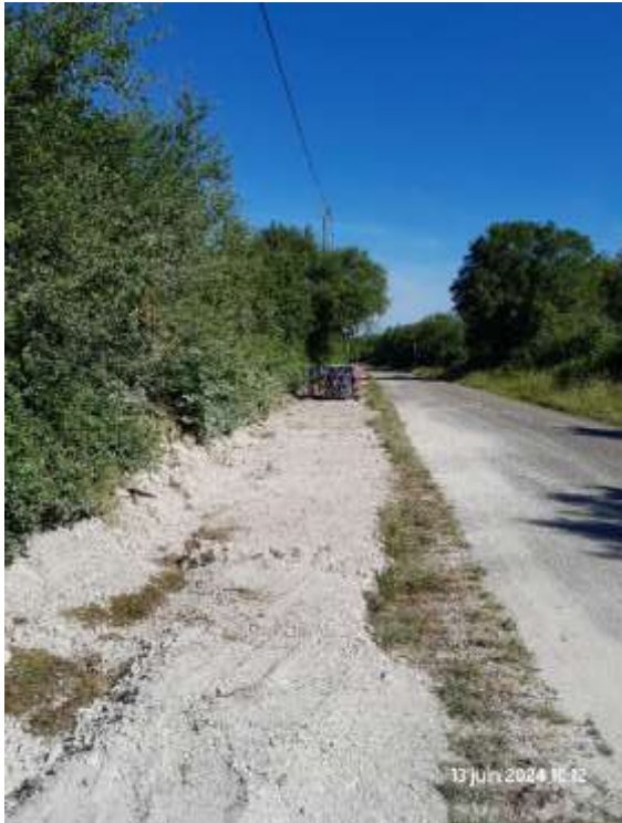
Accotement RD n°11 Tranchée remblayée
