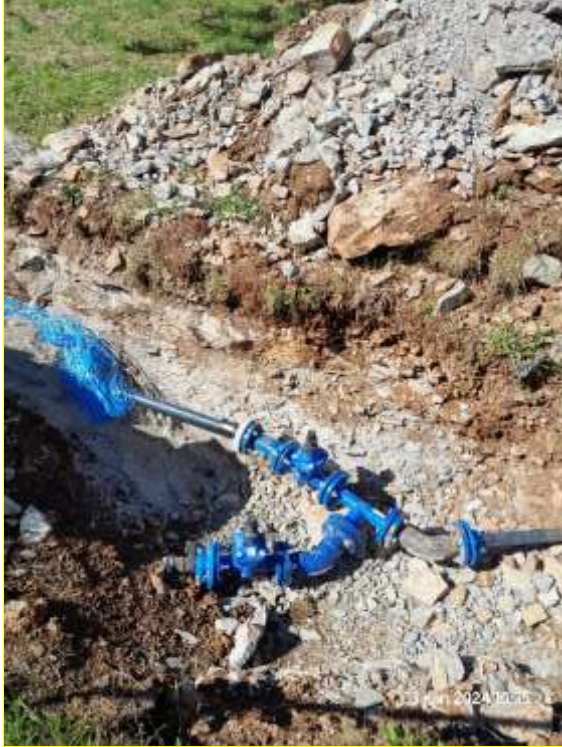
Point de raccordement « Pongens » : Raccordement du PEHD 50 avec bride électrosoudée
