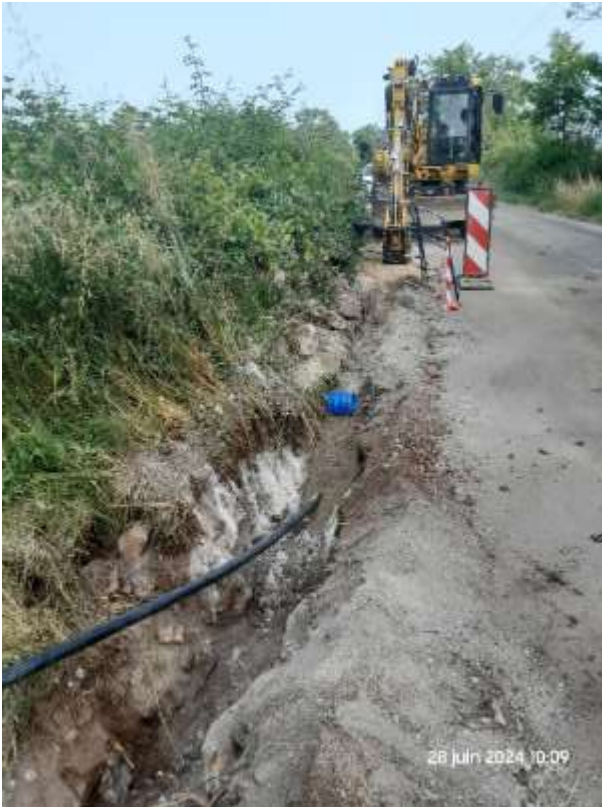
Accotement RD n°11 « Borie de l'Alé » : Pose du PEHD 50 en cours. Profondeur de tranchée à corriger
