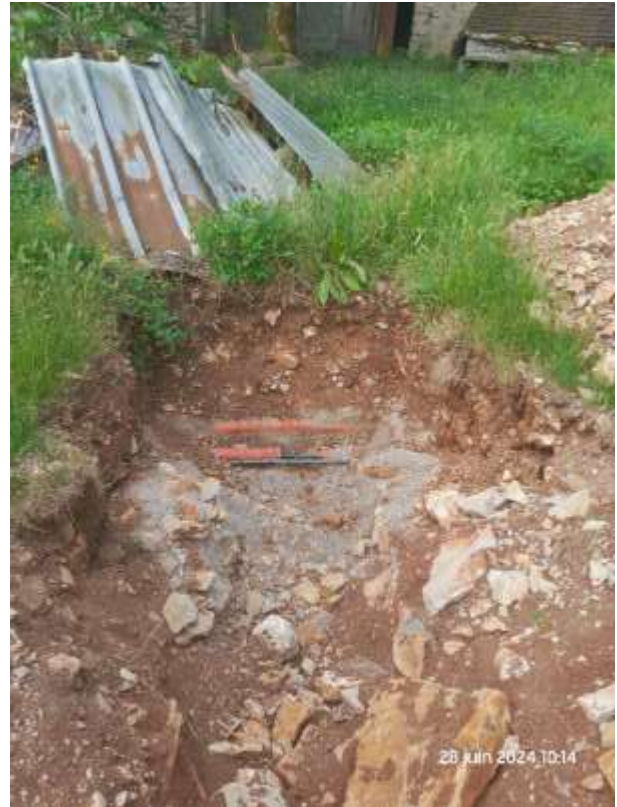
Chez M. BONNET - « Borie de l'Alé » : Point de raccordement de la nouvelle canalisation sur la canalisation existante en PEHD32 posée récemment.
