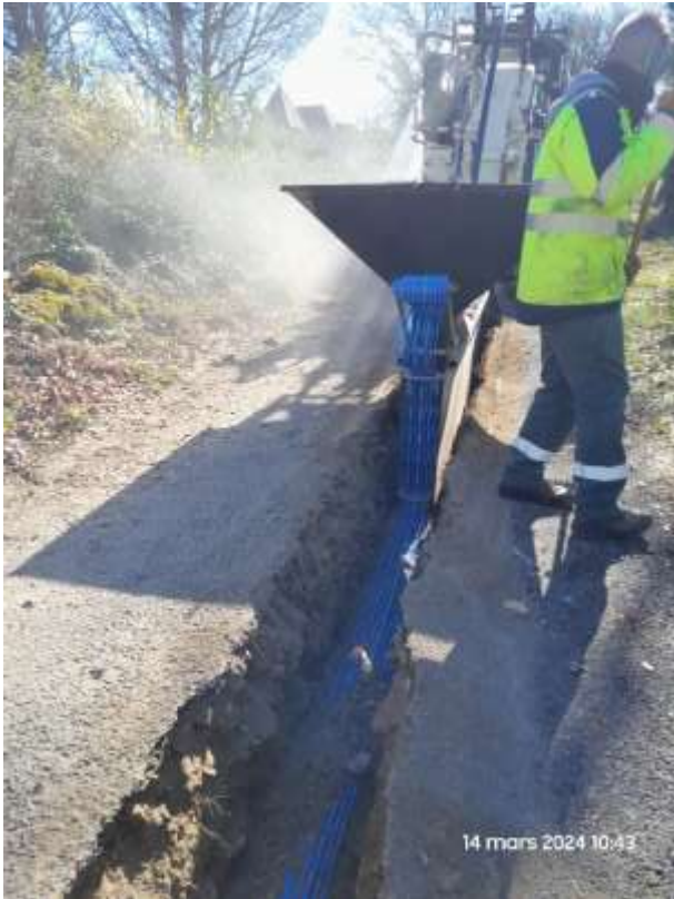
Route du Salvage : Terrassement à la trancheuse en cours pour la pose du PEDH 63
