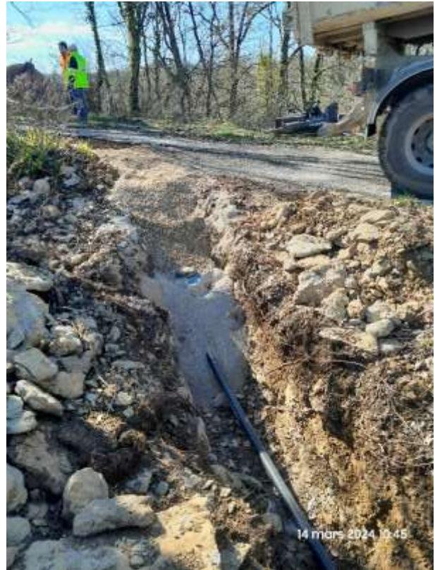
Route du Salvage : Point de raccordement avec le réseau existant
