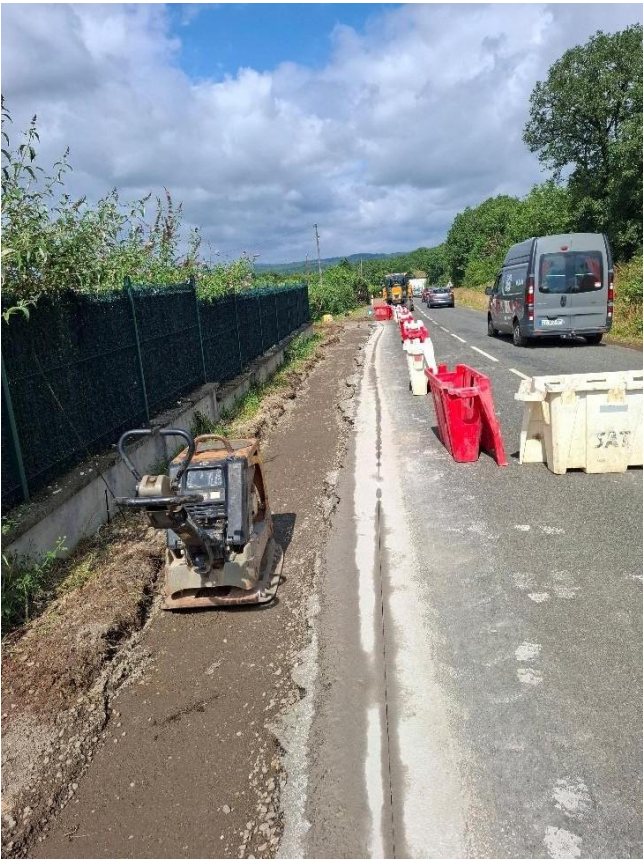
Conduite en PE 50 sous accotement de la RD, partie remblayée
