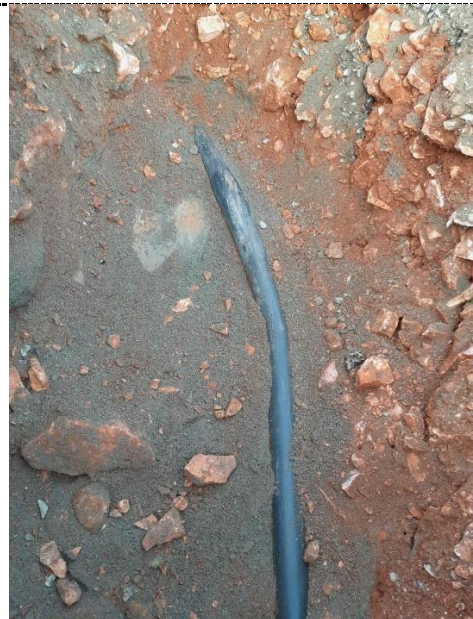
Conduite existante rue des Glycines en PVC 75 collée, chauffée et remblayée en déblai/remblai
