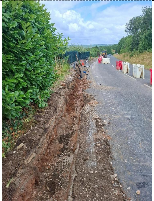
Conduite en PE 50 sous accotement de la RD, terrassement en cours
