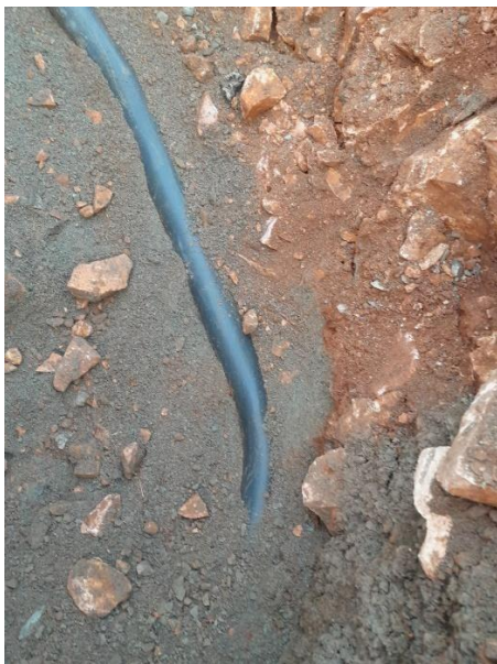
Conduite existante rue des Glycines en PVC 75 collée, chauffée et remblayée en déblai/remblai
