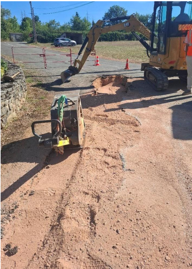
Compactage en cours dernière partie de la rue des Glycines
